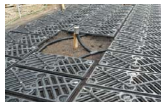
Kabelrør eller plads øverst i SilvaCell
