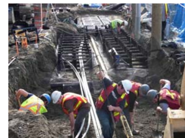
Kabelrør eller plads øverst i SilvaCell
